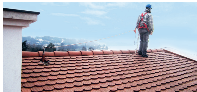
Abb. 3: Ausstattungsstufe 1; Einzelanschlagpunkt (EAP)
